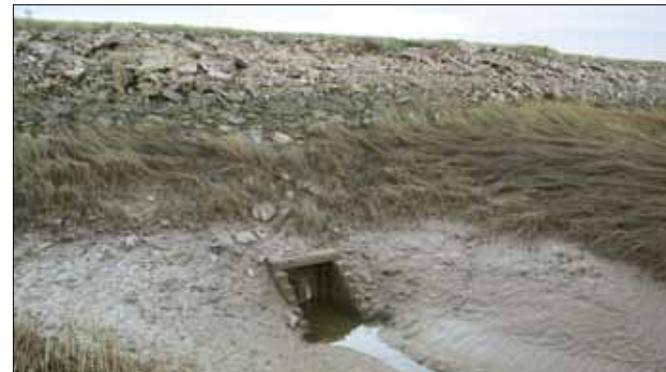
Figure 3-9 Le marais asséché du Paysage de Grand-Pré continue d'être utilisé à des fins exclusivement agricoles. On continue en outre d'y appliquer des systèmes de drainage authentiques, dont l'aboiteau que l'on voit ci-haut pour assécher le marais.
