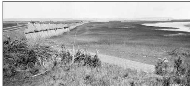
Figures 3-24 et 3-25 Les digues de Grand-Pré sont encore recouvertes de végétation provenant des marais salins. Des parements de roches sont aujourd'hui utilisés pour résister à l'assaut des marées plutôt que les parements de planches de bois, communément employés au XIX<sup>e</sup> siècle.
